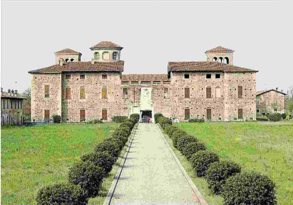
Il castello di Cavernago ricostruito nel 1597 da Francesco Martinengo
