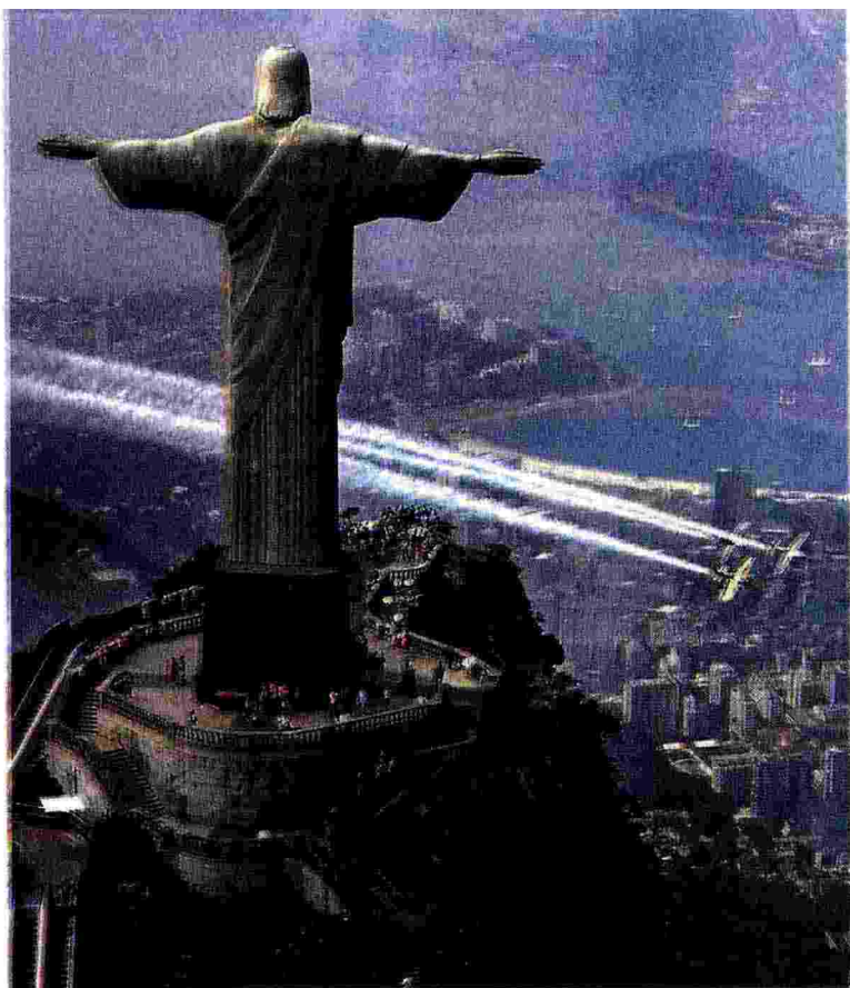
IL REDENTORE DI RIO DE JANEIRO | La statua in cima al Corcovado (a 700 sul mare) è alta 38 metri. Furealizzata in calcestruzzo e pietra saponaria da Paul Landowski e Heitor da Silva e inaugurata nel 1931
